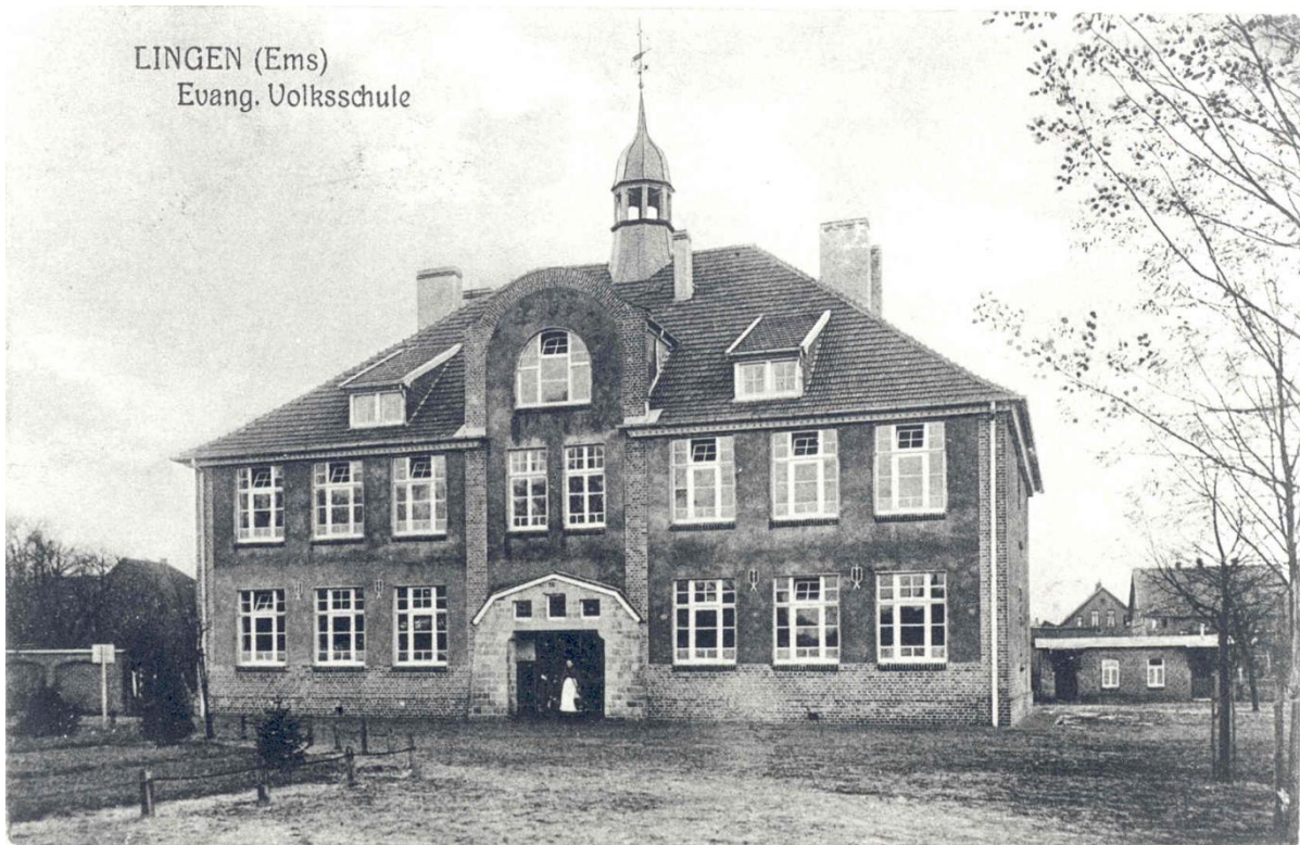
Das 1909 südlich der Marienstraße errichtete Schulgebäude der Evangelischen Volksschule
